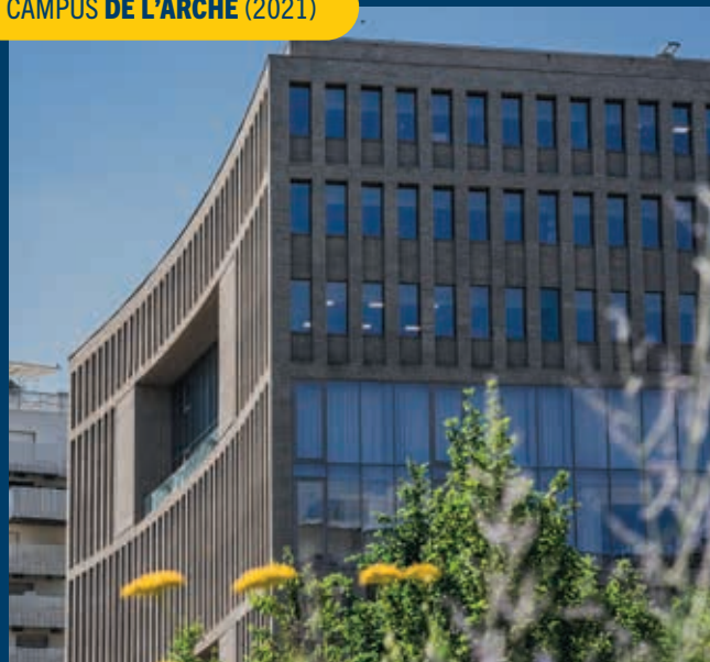
CAMPUS DE L'ARCHE (2021)
